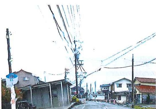
能登半島地震による被害（電柱の倒壊）
